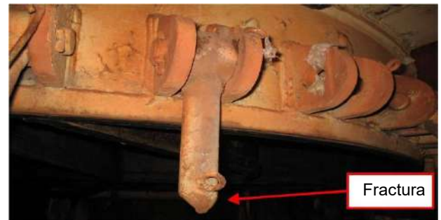
Foto 9 - Abrazadera de fijación con vástago roto en operación en la región soldada (vea las Fotos 7 y 8).
