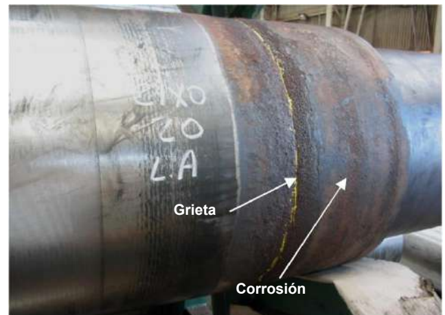
Foto 3 - Eje sin la camisa, con corrosión intensa y formación de grietas en la región de sellado.
