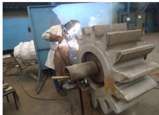
Foto 3 – Rodetes durante aplicação final de solda dura de revestimento.
