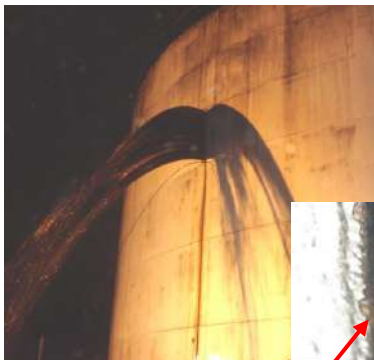
Ruptura da solda do costado causando vazamento de melão em um tanque que foi projetado para receber álcool. No detalhe, a solda que apresentou defeito grave de falta de penetração.
