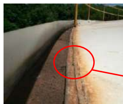
Excesso de solda na fixação do teto com o costado. No croqui ao lado o dimensionamento correto da solda, com dimensão máxima de 3 mm.
