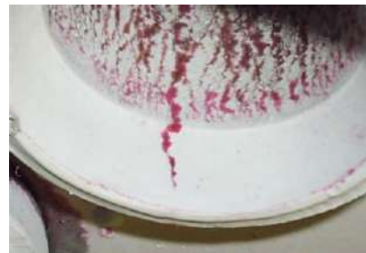
Grande quantidade de trincas ocorridas durante a mandrilagem, ocasionadas pela falta de tratamento térmico na ponta do tubo com redução.
